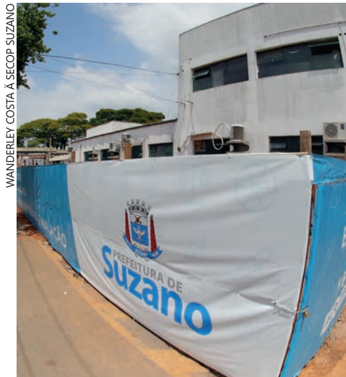
OBRA - PS de Suzano vai ser reformado
